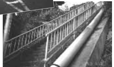
加賀田中学校通学路の東部下町内会集会所より北青葉台へのさびた階段手すりのペンキの塗り替え実施
